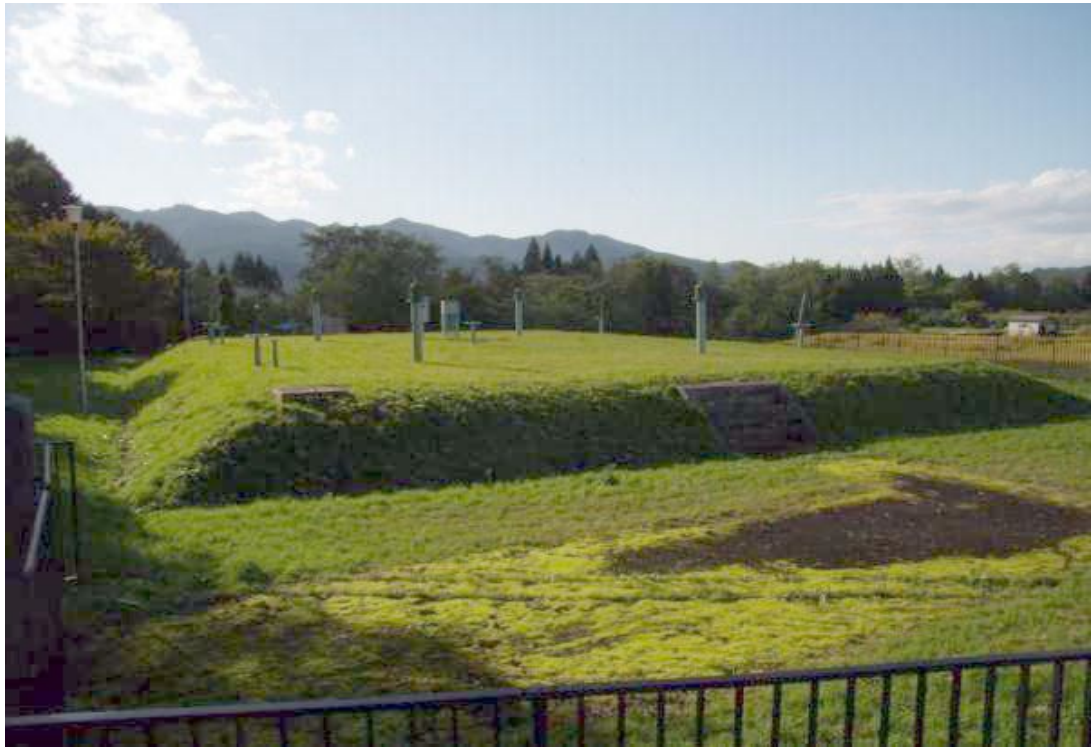
花輪低区配水池
